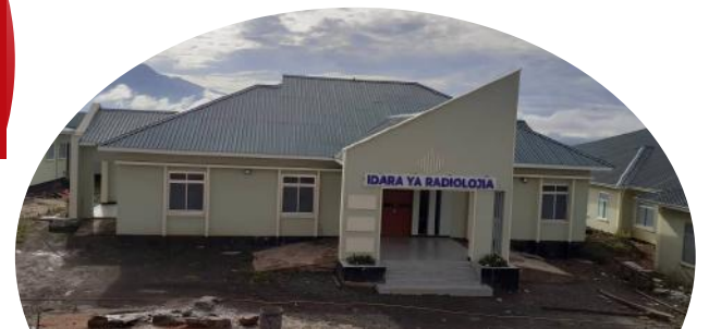
Jengo la idara ya Radiolojia
